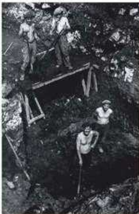
Budowa PKZ-tu rozpoczęła się od prac ziemnych, na terenie podmokłym i częściowo niezabudowanym. Większość prac była wykonywana ręcznie.
