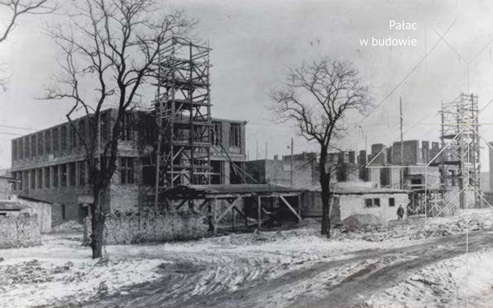
Pałac Kultury Zagłębia został wybudowany z cegły, a elewacje zostały wykończone okładzinami z piaskowca.
