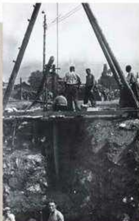
Budowa PKZ-tu rozpoczęła się od prac ziemnych, na terenie podmokłym i częściowo niezabudowanym. Większość prac była wykonywana ręcznie.
