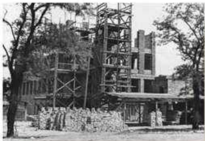
Większość prac budowlanych prowadzona była bez użycia sprzętu zmechanizowanego.
