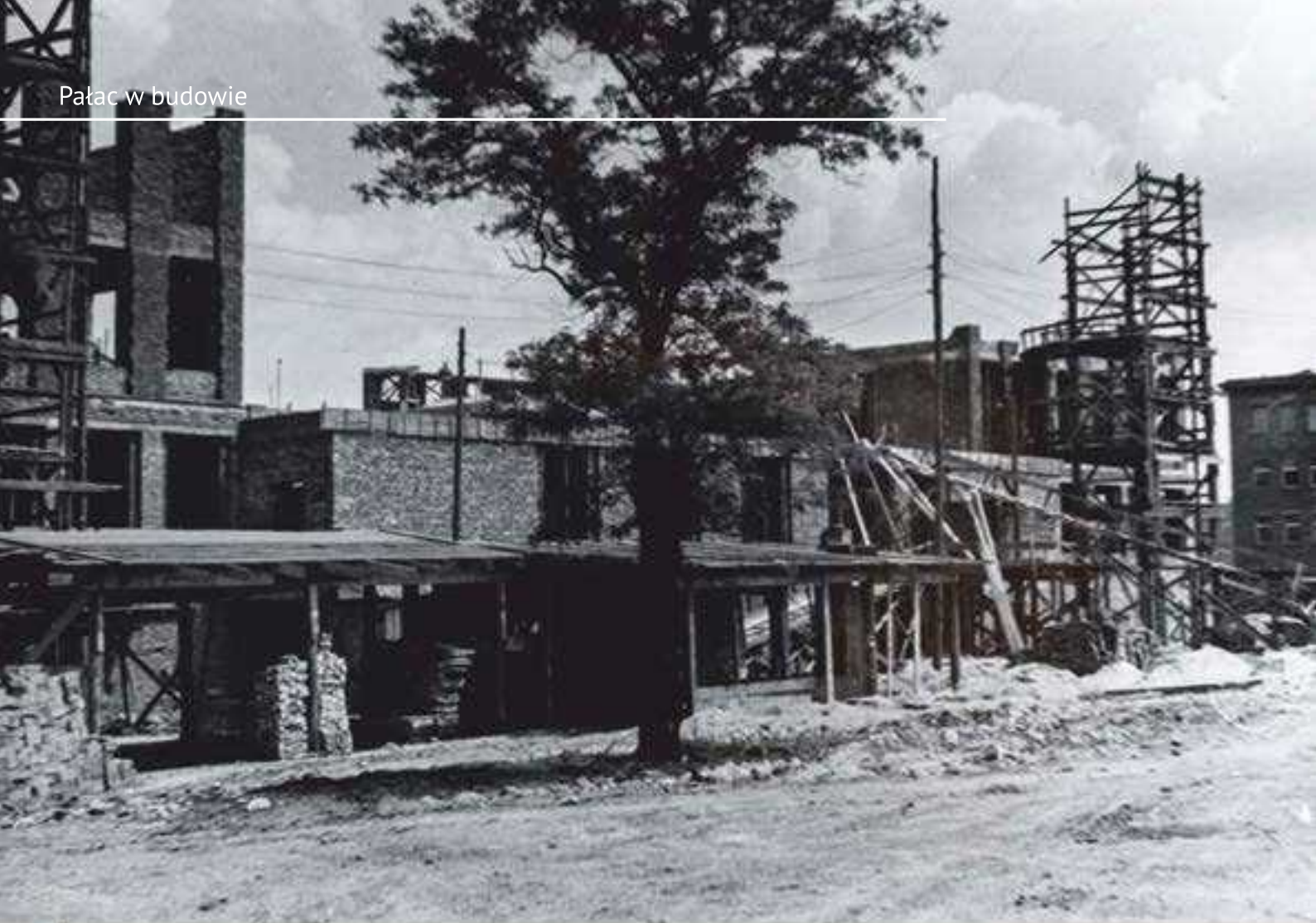
Widok na elewację frontową od strony Placu Wolności.
