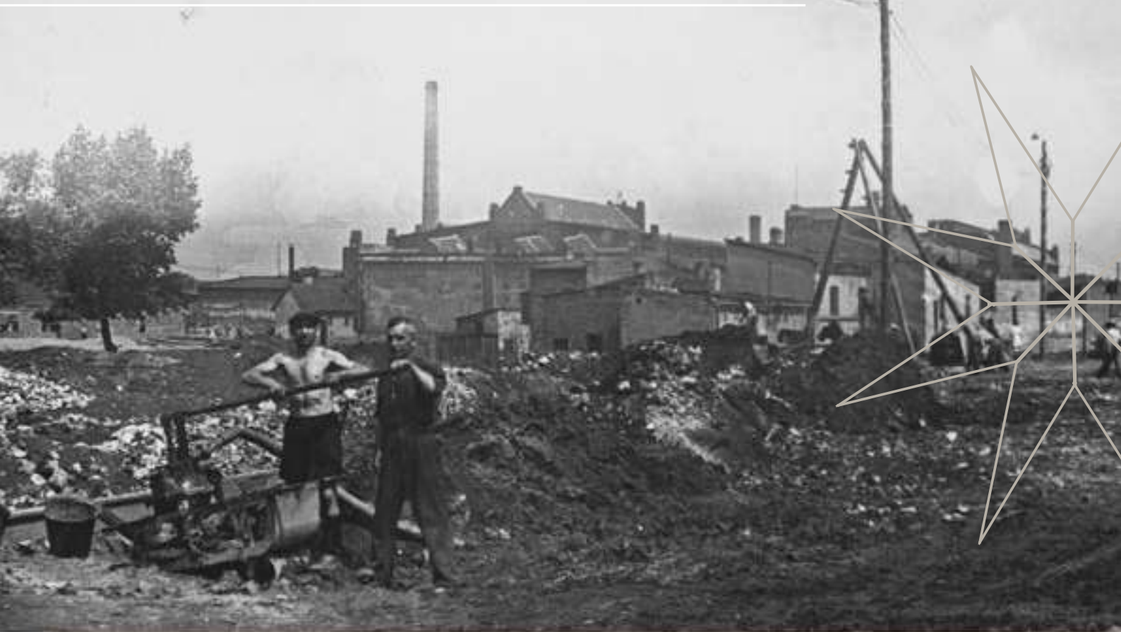
Prace ziemne podczas budowy PKZ. W tle widoczne zabudowania obecnej Fabryki Pełnej Życia.
