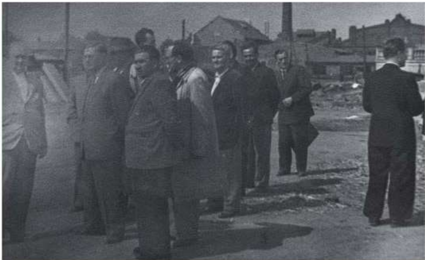
Drugi z lewej Aleksander Zawadzki podczas inspekcji prac budowlanych.
