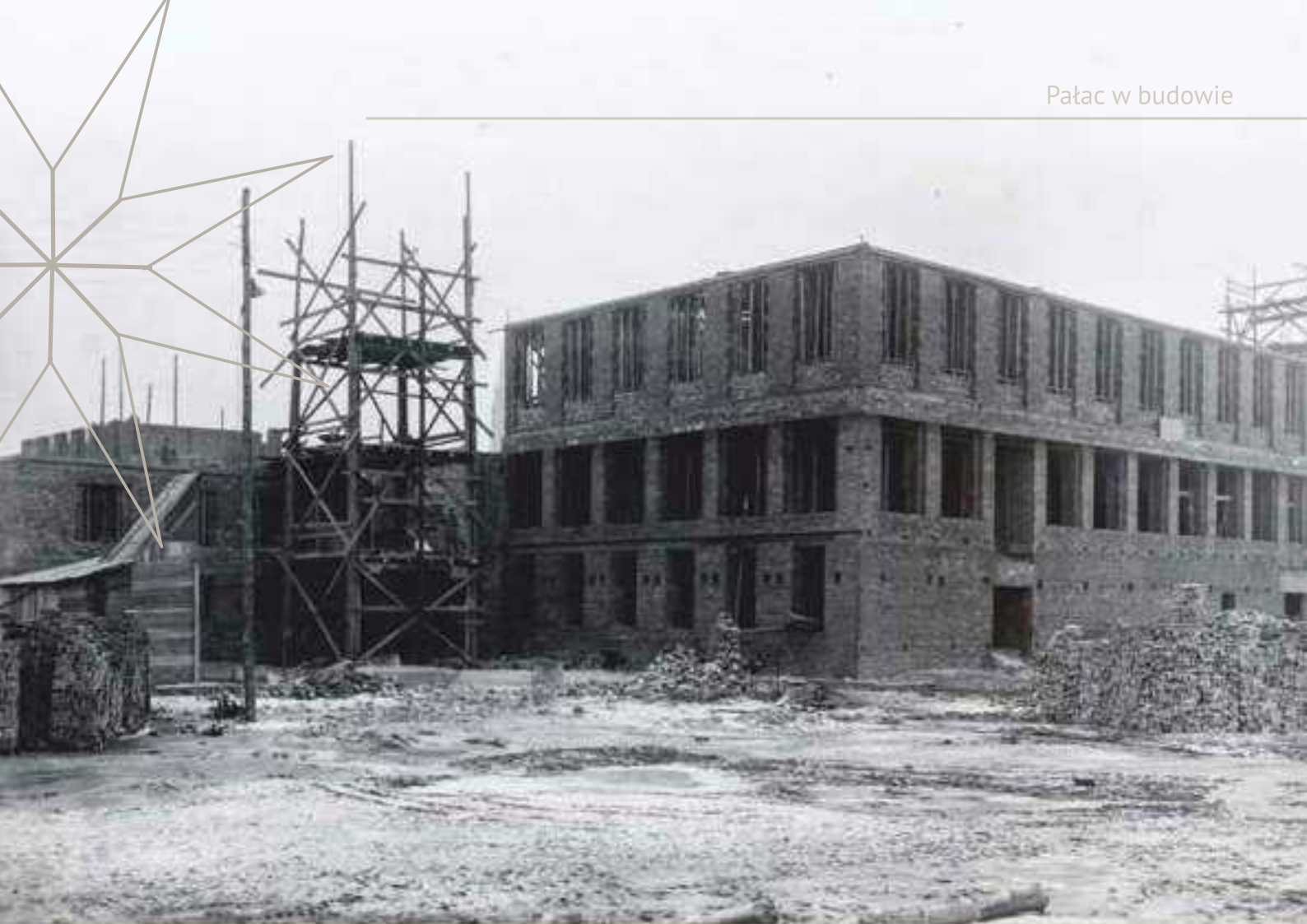
Większość prac budowlanych prowadzona była bez użycia sprzętu zmechanizowanego.
