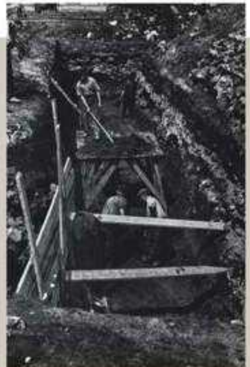
Budowa PKZ-tu rozpoczęła się od prac ziemnych, na terenie podmokłym i częściowo niezabudowanym. Większość prac była wykonywana ręcznie.
